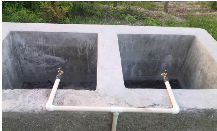
Figure 16 : Bassin de lavage, désinfection et rinçage des seaux
