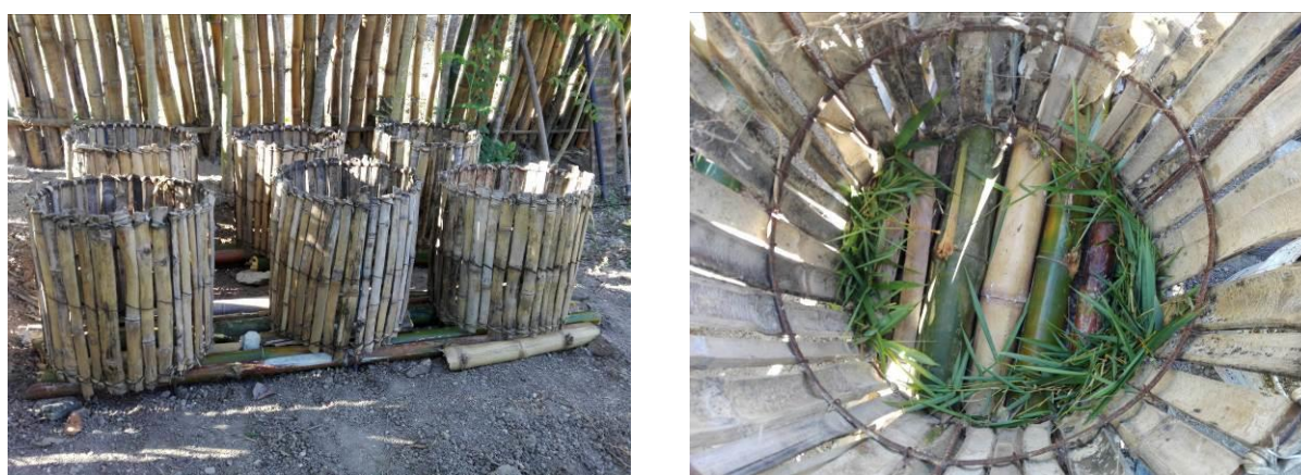
Figure 25 : Pilotes de 100 litres
