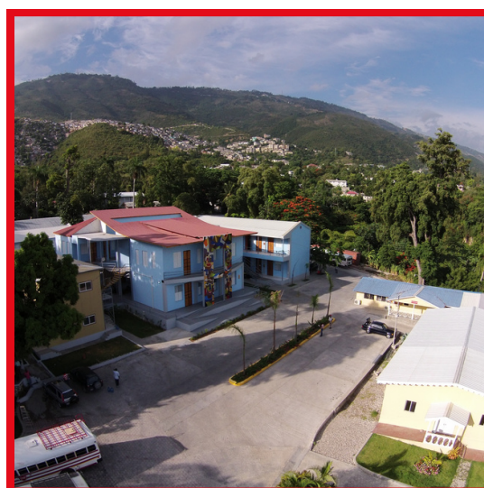
Campus de Turgeau - Locaux actuels de l'UniQ, reconstruits après le séisme de 2010
