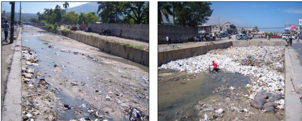
Figure 34: la ravine Bois de chêne, le plus grand collecteur du système de drainage de la ville de Port-au-Prince
